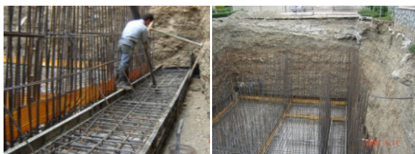
کارگذاری Water Stop
