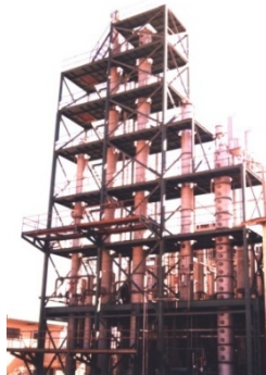
ستون ها Columns
